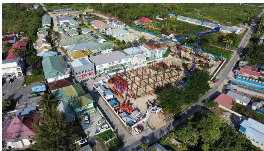
Gambar 3.6 Pelaksanaan Pembangunan Lokus Batch 3 – RSUD Cendrawasih Dobo
